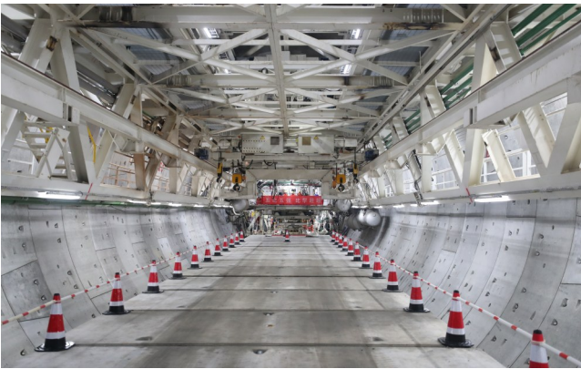
建设中的艮山东路过江隧道工程
