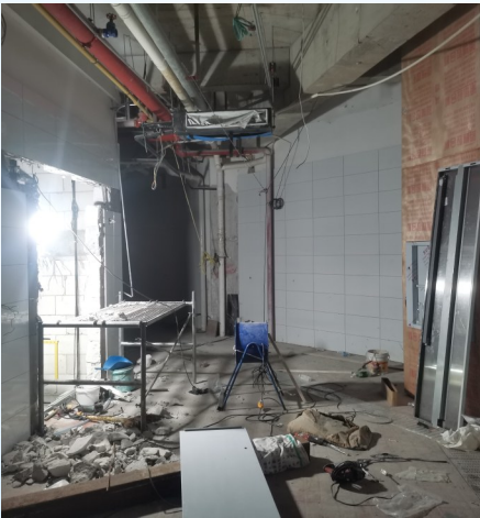
图为施工现场
