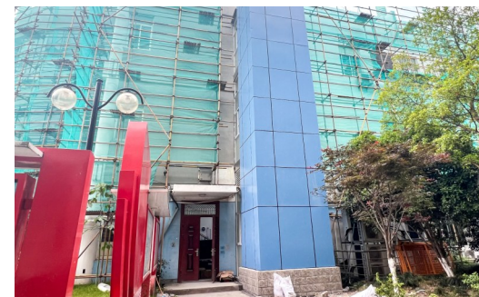
白杨街道邻里社区邻里中心小区电梯加装外景
