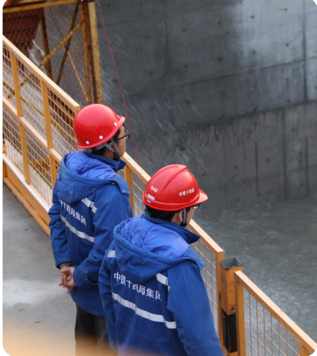
杭州下沙路项目左线盾构机“钱塘奋进二号”接收时,两位技术人员严格按照施工要求工作,确保施工安全。
