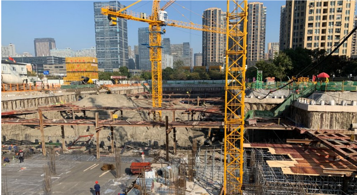
图为中心区人才房项目,目前,地下室主体结构已进入施工阶段。
