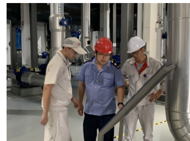
管道465公里,消除隐患2850处。同时,积极推进特种设备在线及数字特监系统的运用,落实特种设备赋码工作,守好监管底线。
