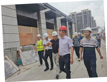
建筑工地大排查大整治
