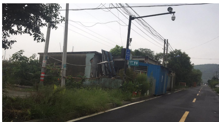
河庄街道三联村19组12号东侧 路边违建、脏乱差
