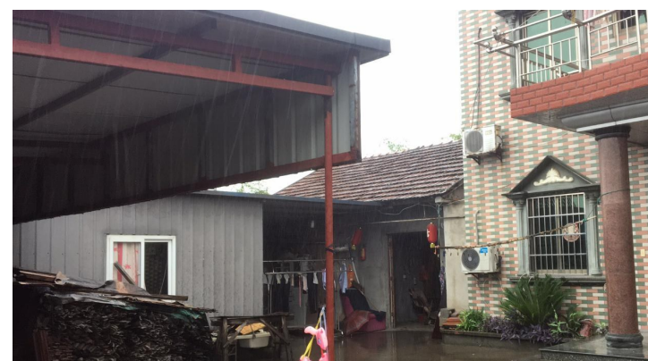
临江街道萧东村22组242号 围墙内彩钢棚
