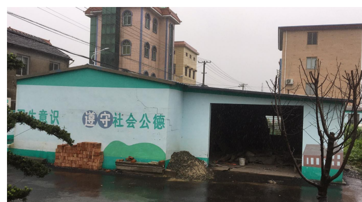
临江街道东庄村村委会向东300米路口 路边违建
